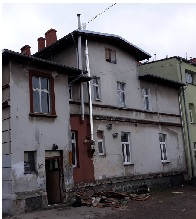
Gryfice, ul. Ks. Stanisława Ruta 13 - elewacja północna
