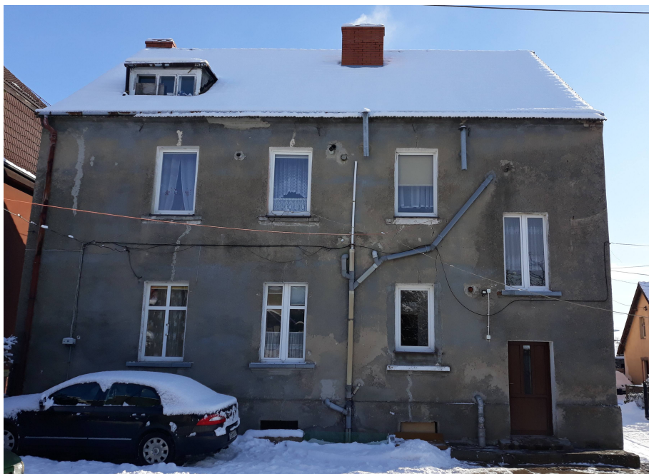
- Gryfice, ul. Rapackiego 23 elewacja zachodnia
