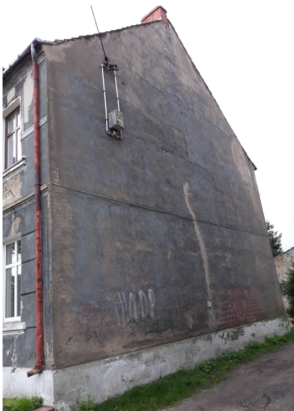
- Gryfice, ul. Rapackiego 23 elewacja północna
