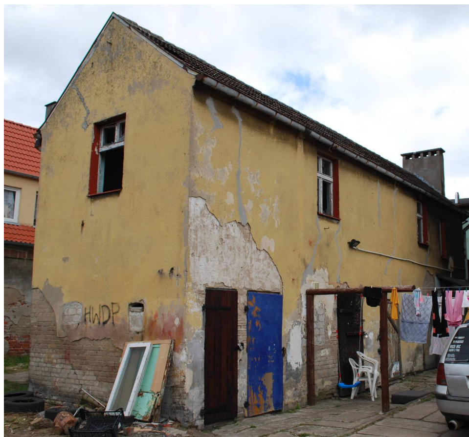
Gryfice, dz. nr 220/8 i 220/6— rozbiórka budynku gospodarczego - elewacja południowa i zachodnia
