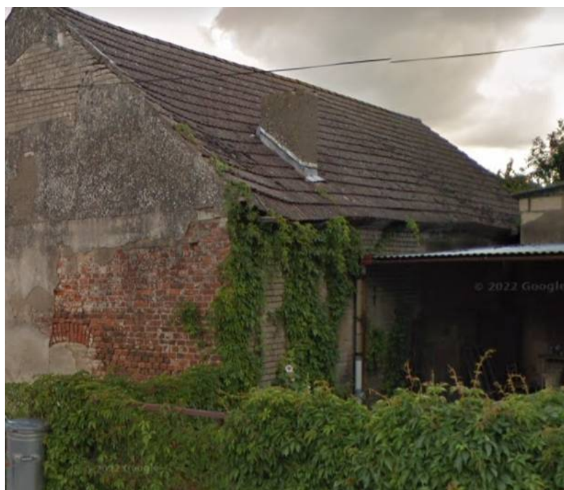
Gryfice, dz. nr 223– rozbiórka budynku gospodarczego - elewacja południowa
