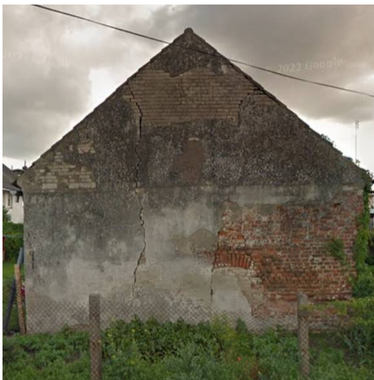
Gryfice, dz. nr 223– rozbiórka budynku gospodarczego - elewacja zachodnia
