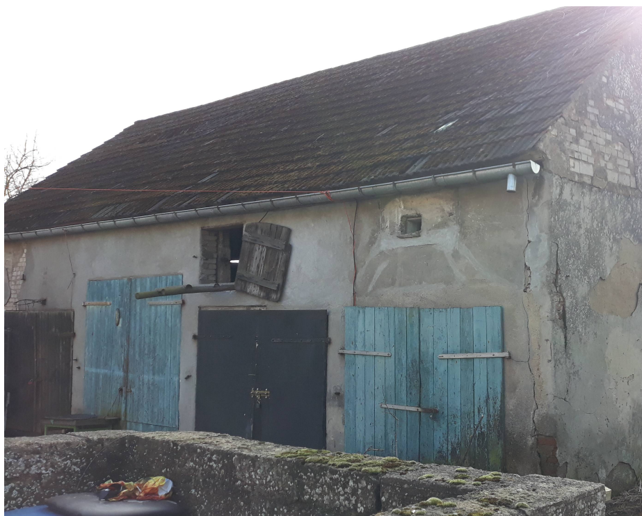
Gryfice, dz. nr 223– rozbiórka budynku gospodarczego - elewacja północna i zachodnia
