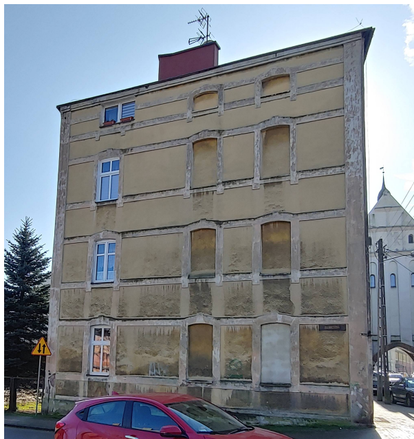
Gryfice, ul. Kamienna Brama 1- elewacja północna
