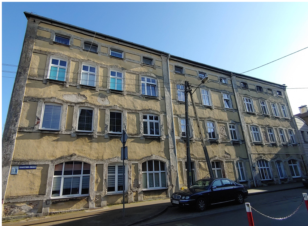
Gryfice, ul. Kamienna Brama 1- elewacja zachodnia
